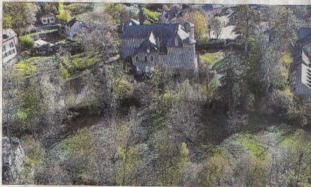
■ La conduite qui traverse la propriété du château des Ondes doit être enlevée...
