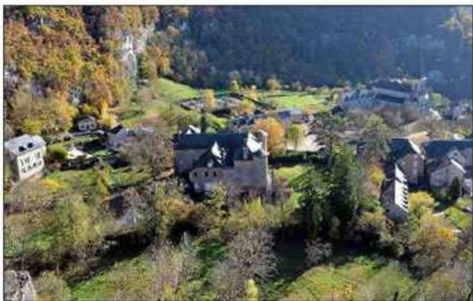
Le château des Ondes dont les terres sont traversées par la conduite forcée.
